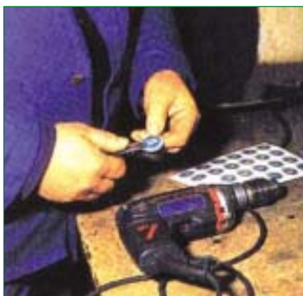
בדיקת ציוד חשמלי ע"י החשמלאי תסתיים בהדבקת "תווית בדיקה ואישור תקינות". את התווית מחדשים בעת ביצוע הבדיקה התקופתית, במועדה
